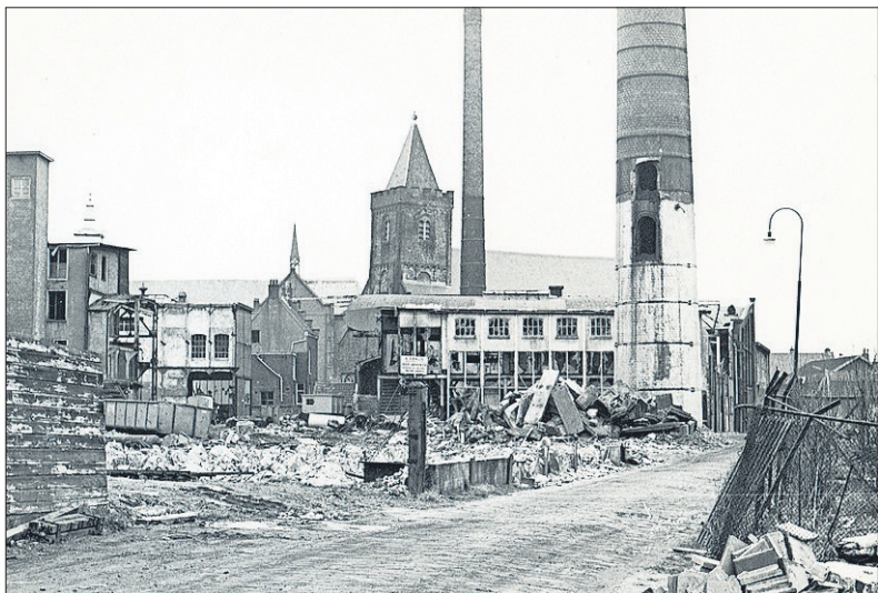
■ Bouvy zoutfabriek tijdens de sloop in 1974.
