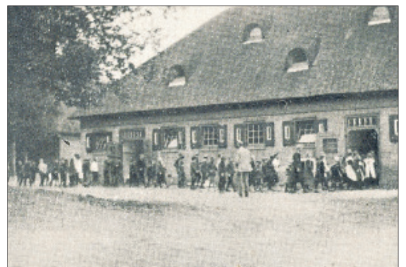
■ De ingang van de eetzaal.
