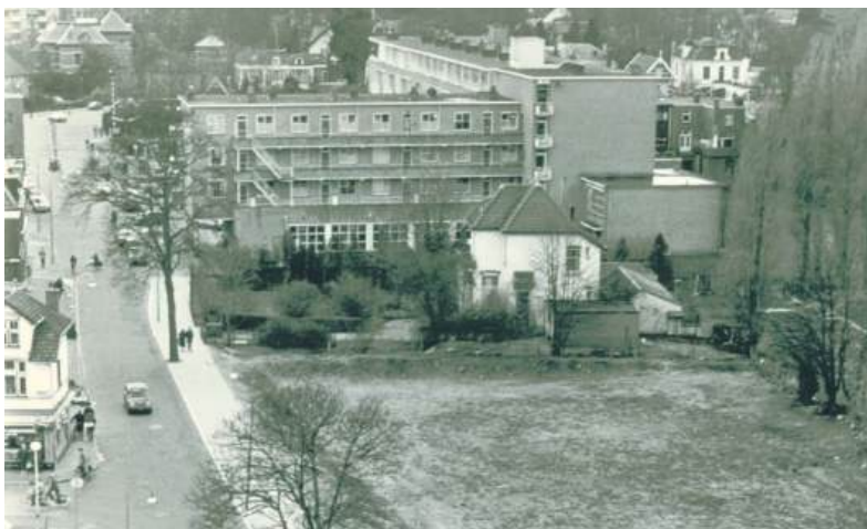
■ Achter de HEMA staat nog het huis van de fotograaf, de overige huizen zijn gesloopt.
