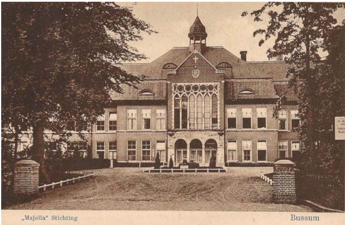
■ De hoofdingang aan de Iepenlaan.
