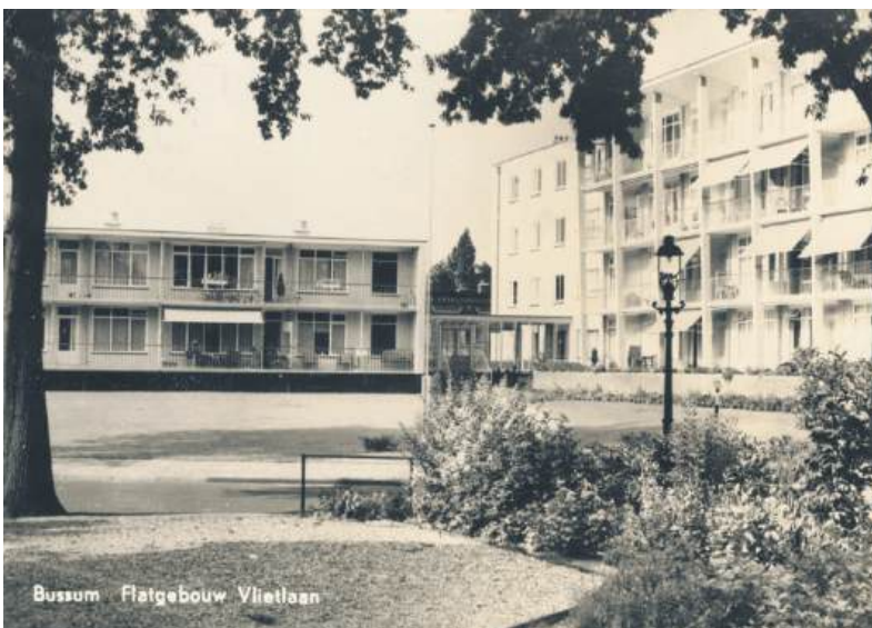
■ Appartementengebouw Hessen Cassel.
