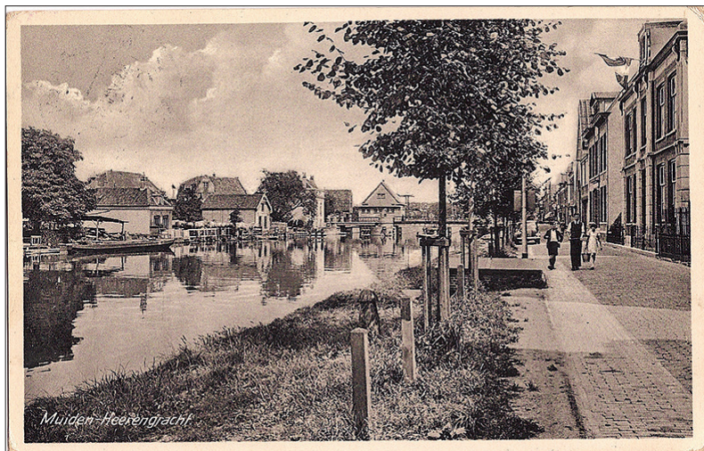
Heerengracht Zuid met in het midden het pompgebouw.
