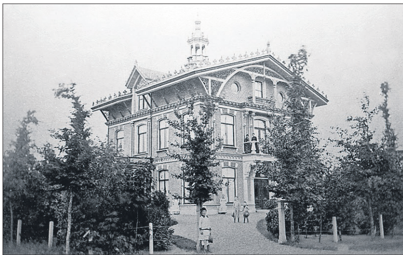
■ De villa Nieuwburg rond 1900.
