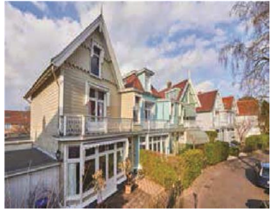
De houten huizen aan de Sandtmannlaan
