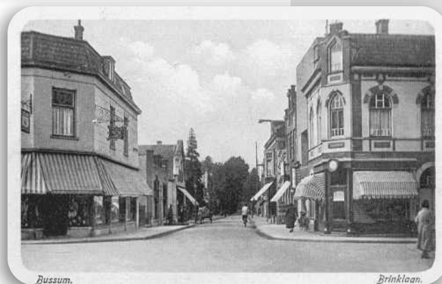
Brinklaan richting Naarden, links Nassaulaan, rechts Havenstraat
