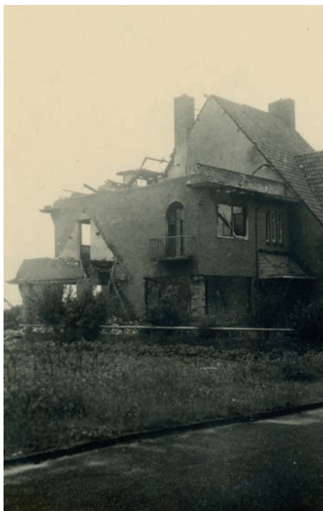
De afgebrande villa aan de Juliana van Stolberglaan
