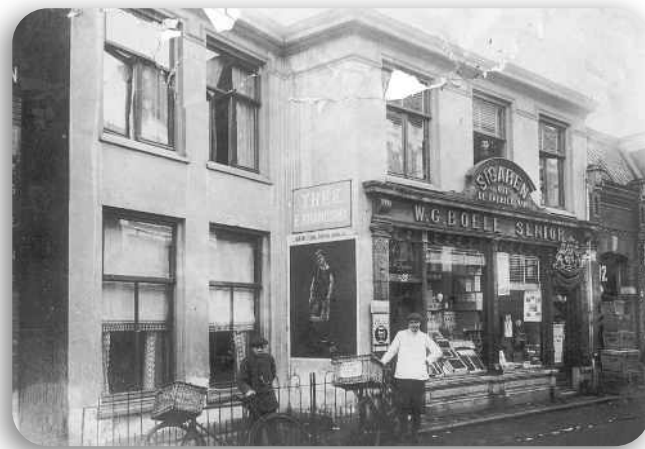
Nassaulaan 27 (voorheen 25), een vroege winkelpui, stenen basement met houten raampartij
