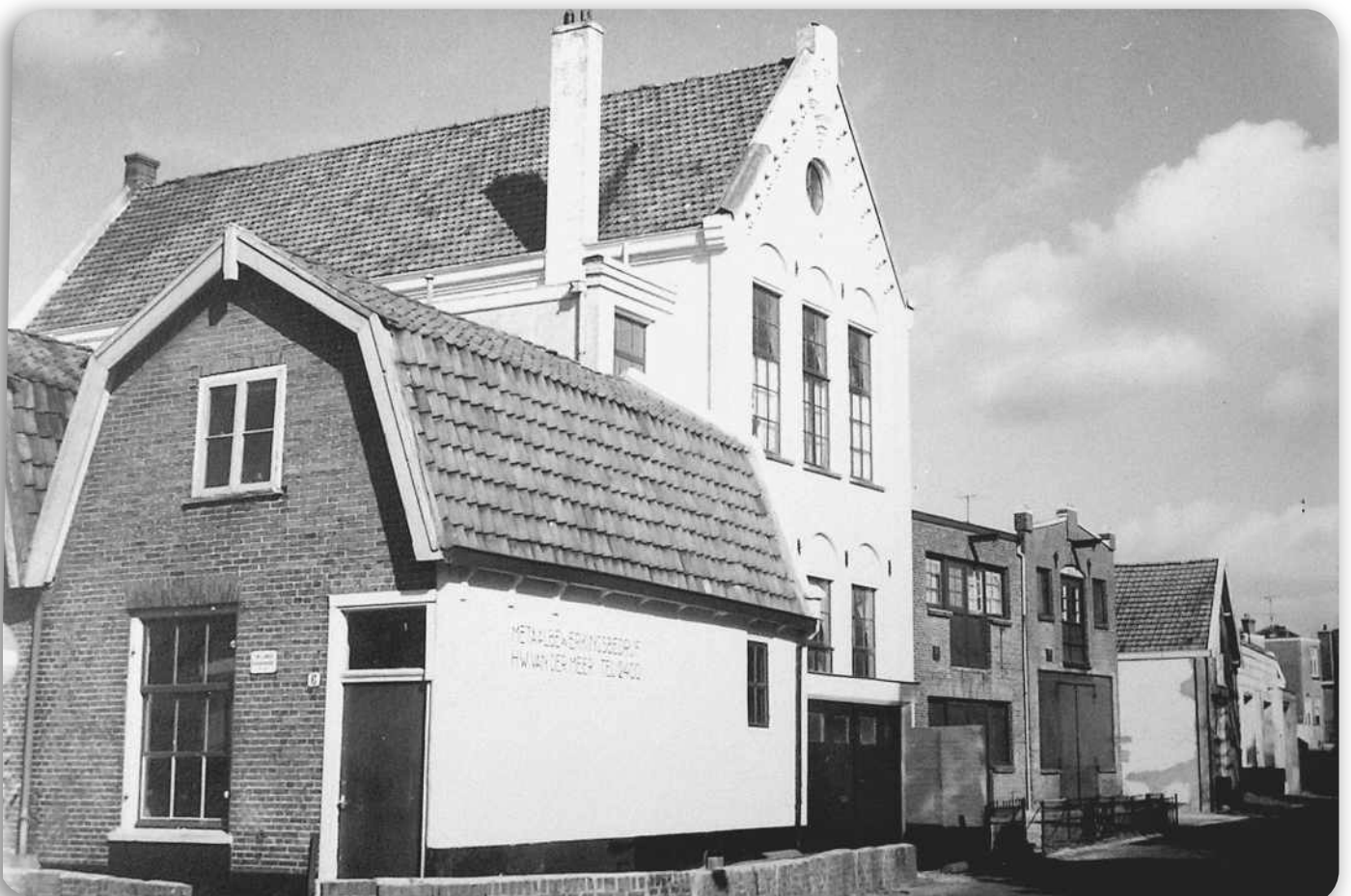
Bewaarschool aan de Veldweg, het huisje links naast de woning op de voorgrond staat er nog
