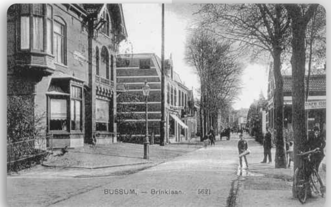
Brinklaan met rechts de Veerstraat, in de richting Havenstraat, rechts Café Delta, nu McDonalds, links nu de bibliotheek; in de verte slagerij Hogenbirk, op de hoek van de Veldweg
