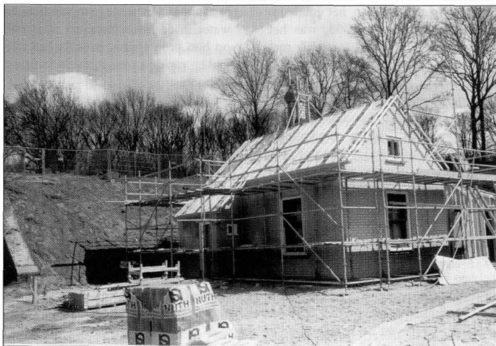
Fortwachterswoning in aanbouw
