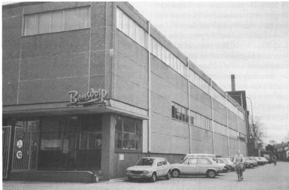
Het massieve Bendsorp (de ingang van het personeel), zoals het de Bussummer het meest zal bijblijven. Verwerkt beton 1513 m 3 , betonstaal 178845 kg. Stalen balken, kolommen en diversen 130.000 kg. Totaal gewicht nieuwbouw 5.000.000 kg. Foto Martin Heyne.
