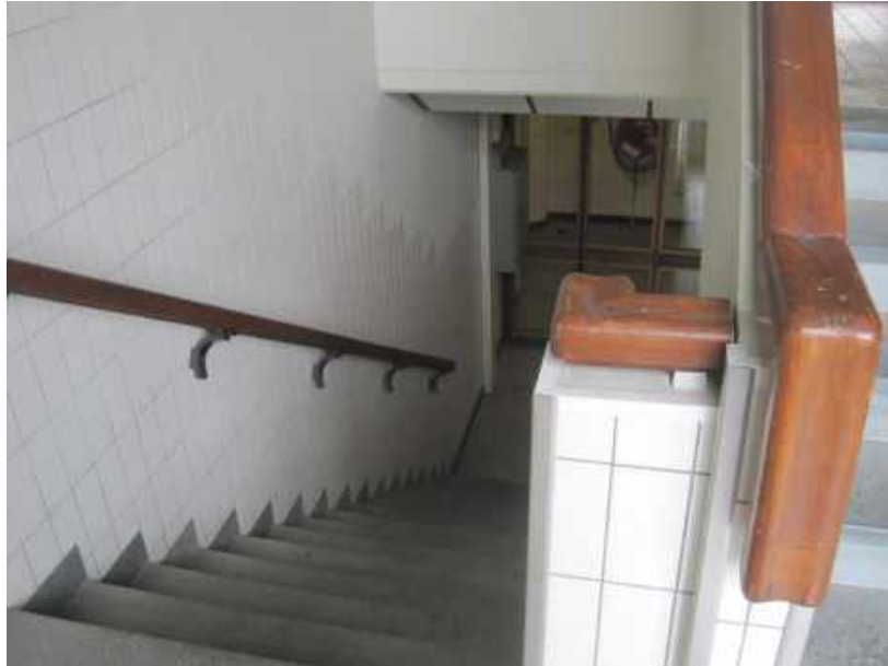
Figuur 48. Gedeelte leuning en tegels trappenhuis gebouw 2.
