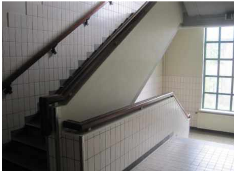
Figuur 46. Trappenhuis gebouw 2.
