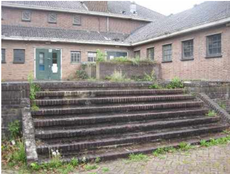
Figuur 49. Voorzijde Keukengebouw met trap.
