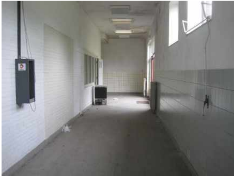
Figuur 56. Gang op begane grond Keukengebouw.
