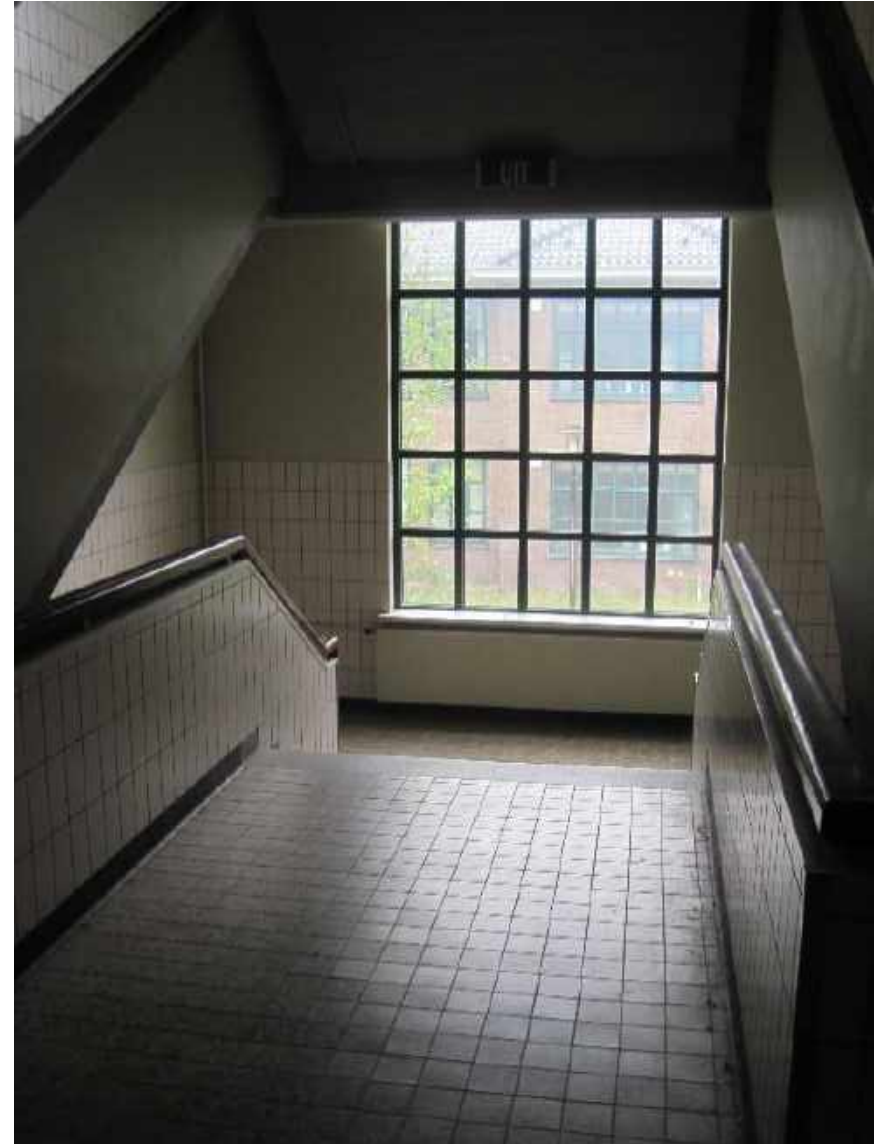
Figuur 44. Trappenhuis gebouw 2.
