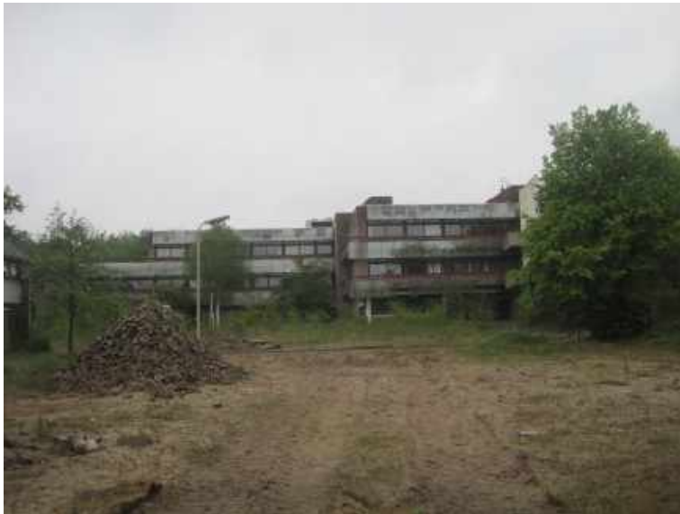
Figuur 60. Gebouw Spiegelhorst voorkant.
