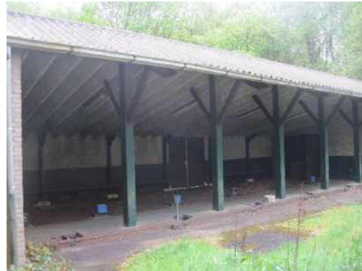
Figuur 90. Kapschuur schietbaan.
