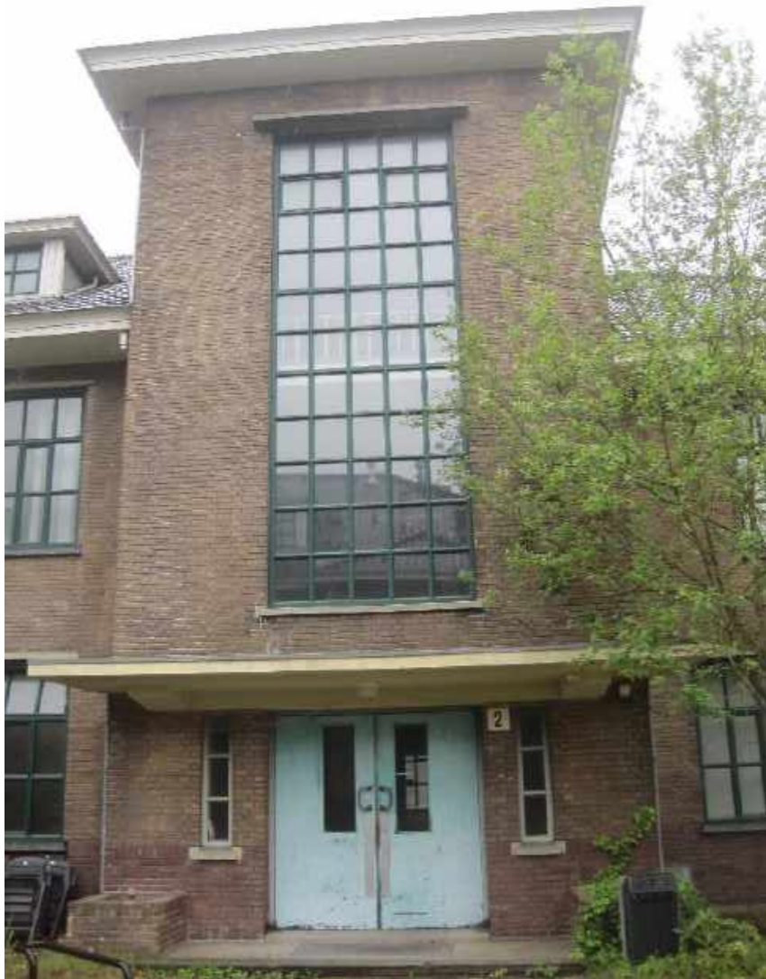
Figuur 45. Voorportaal gebouw 2.
