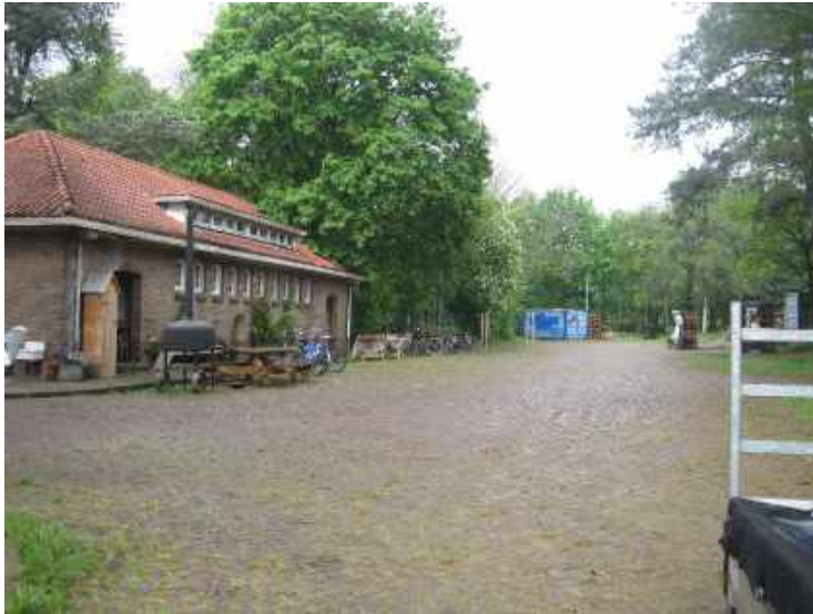
Figuur 94. Eén van de twee badhuizen op terrein. Gebouw AZC-26.
