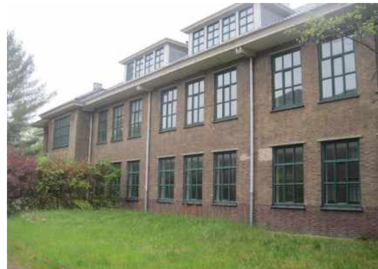
Figuur 43. Achterzijde gebouw 2.
