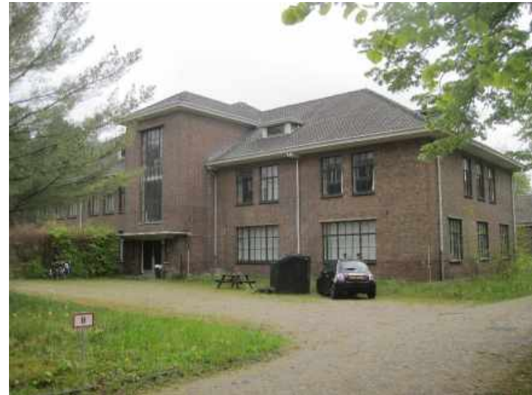
Figuur 41. Voorzijde gebouw 3.
