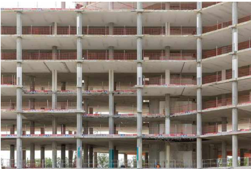
Figuur 17. Voorbeeld hergebruik betonskelet, Rijkskantoor de Knoop.
