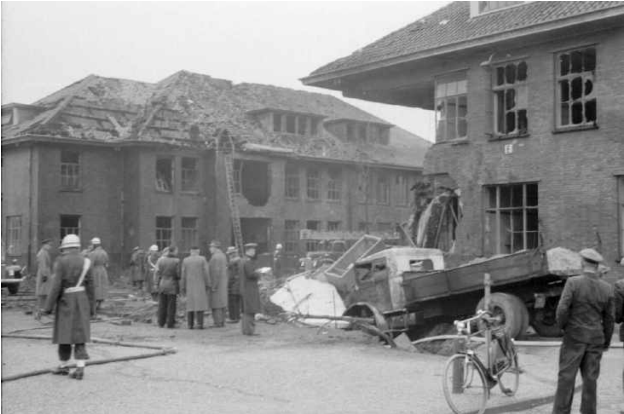
Figuur 32. Foto genomen na de crash. Gebouw 2 en 3 zijn gedeeltelijk kapot.
