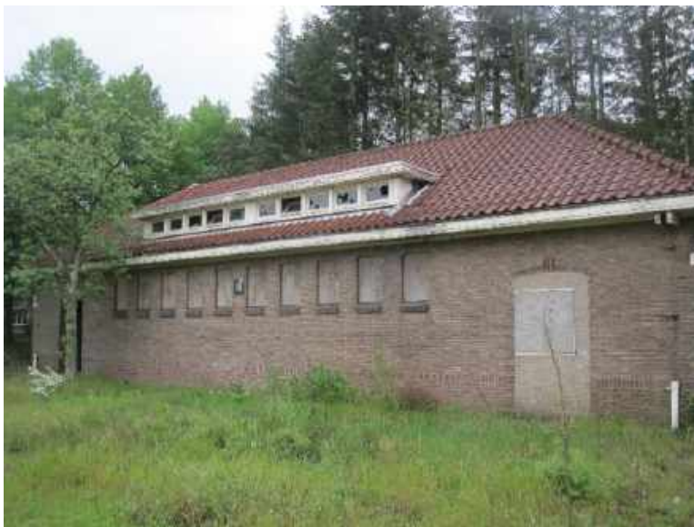
Figuur 97. Eén van de twee badhuizen op terrein. Gebouw AZC-18.
