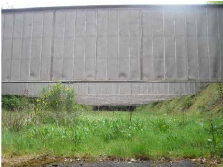
Figuur 92. Kogelvangens van de schietbaan.
