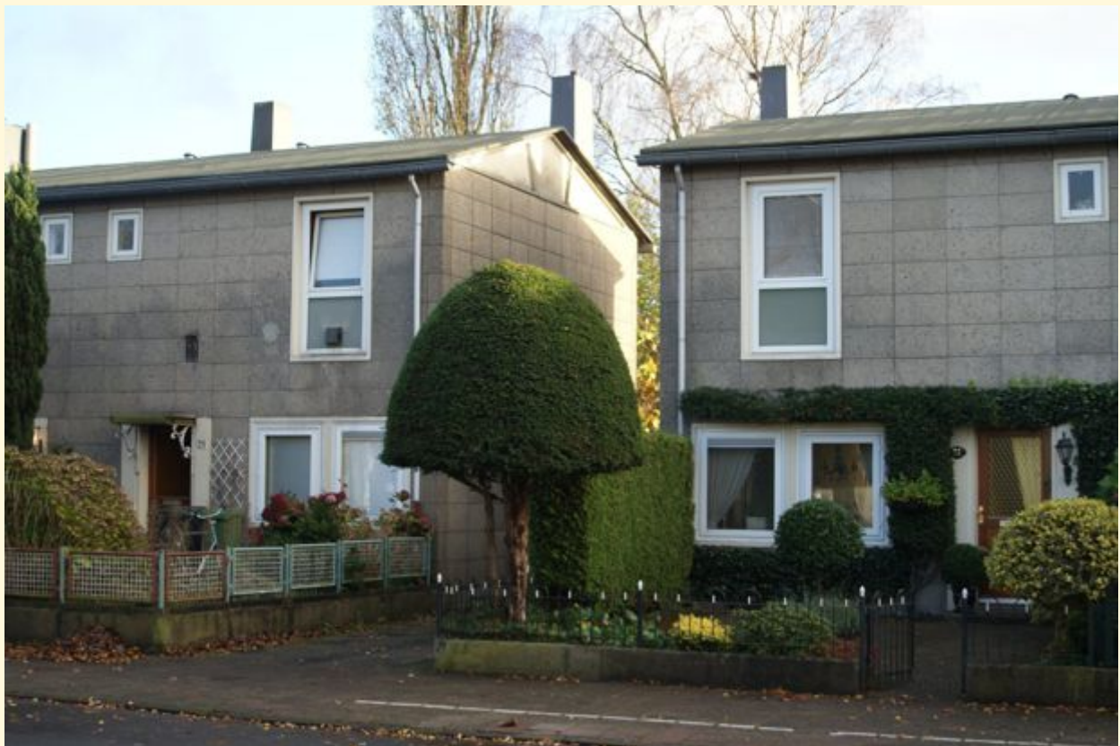
Airey woningen in de Bottemastraat
