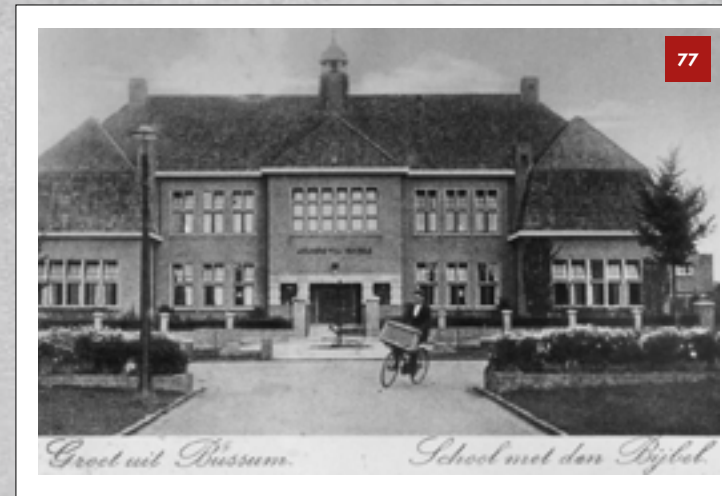
De School met den Bijbel aan het Eendrachtspark, gebouwd in 1923.
