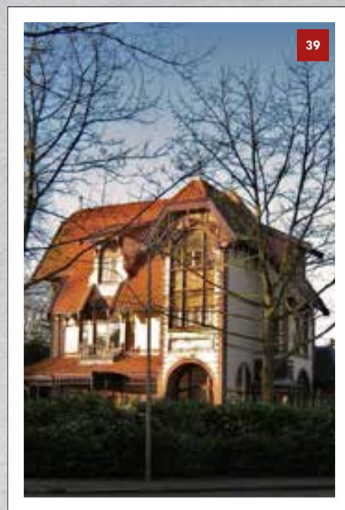
Villa Vreeland, Parklaan 37, gebouwd in 1902. De architecten waren A.J. Jacot en W. Oldenwelt.
