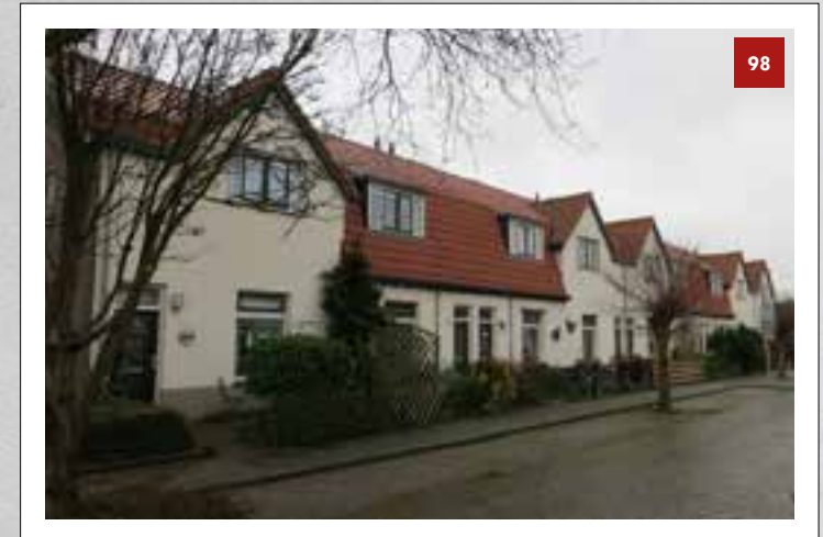
De huizen in het St. Josephpark uit 1914 kregen later een dikke piepschuim-isolatielaag tegen de buitenmuur.
