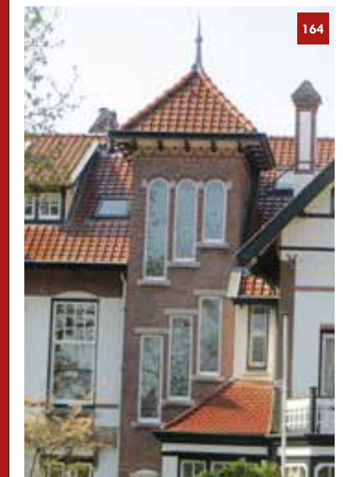
Graaf Florislaan 1 uit 1899. Het trappenhuis heeft glas-in-lood ramen en een 4-delige spits.
