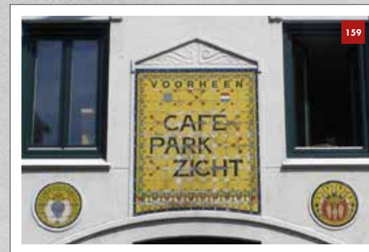
De zijkant van restaurant Achibald, Brinklaan 25, kijkt uit over het Prins Hendrikpark.
