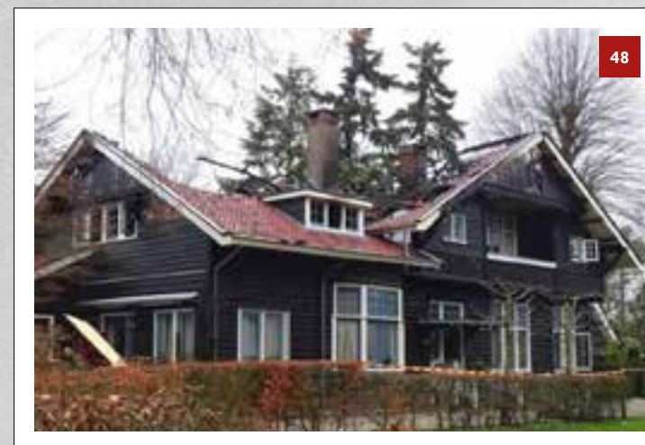
Het risico van houten huizen: brand. Deze villa aan de Nieuwe 's-Gravelandseweg ging in 2018 in vlammen op.
