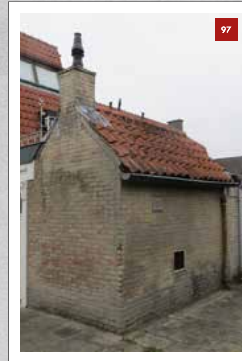
Een van de weinige originele schuurtjes (2 bij 3 meter) in het St. Josephpark uit 1914. In de schuurtjes werd de was gedaan.
