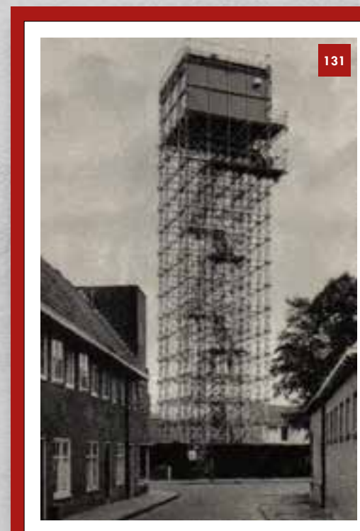
De dertig meter hoge televisietoren die werd opgericht aan de Nieuwstraat om ongestoord de centrale zendmast in Lopik te kunnen bereiken.
